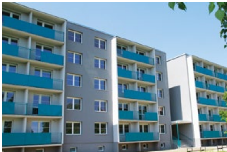
Dům v Přichystalově ulici v nové podobě a zrekonstruovaném stavu. Zdroj foto: 2x MmOl, Blanka Martinovská
