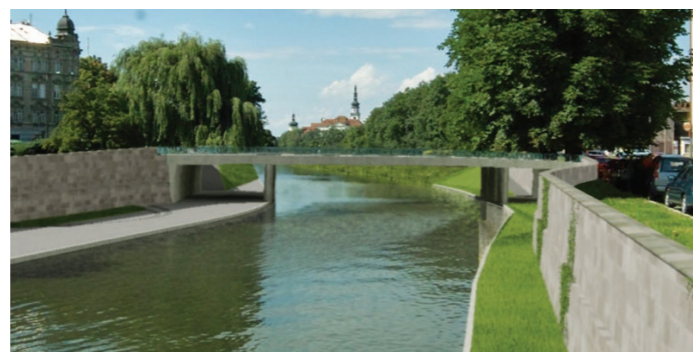
Vizualizace protipovodňových opatření II. B etapy, které zachycují úpravu koryta Moravy. Zdroj: Povodí Moravy, s. p.
